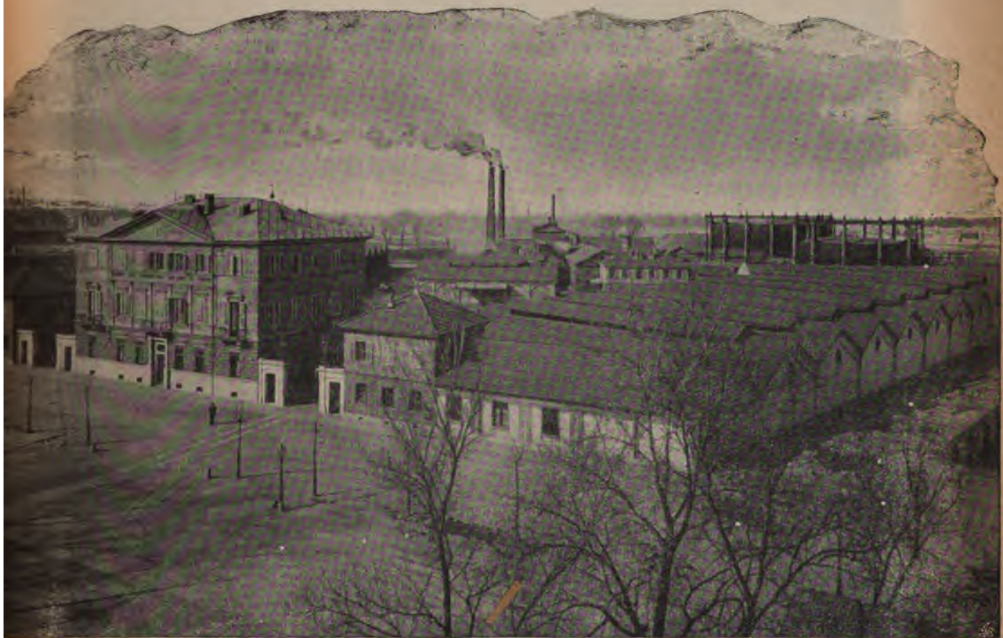
Veduta generale della Officina della Società dei Consumatori gaz di Torino
